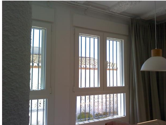
Foto 3: Es werden keine nennenswerten Wärmebrücken an den Anschlüssen zwischen Fenstern/Türen und Wandflächen festgestellt (innen).
